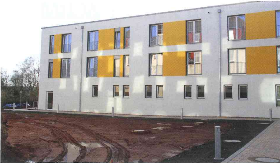
Bei den Bauarbeiten deutlich zu sehen: die rote Erde des Marburger Rotenbergs
