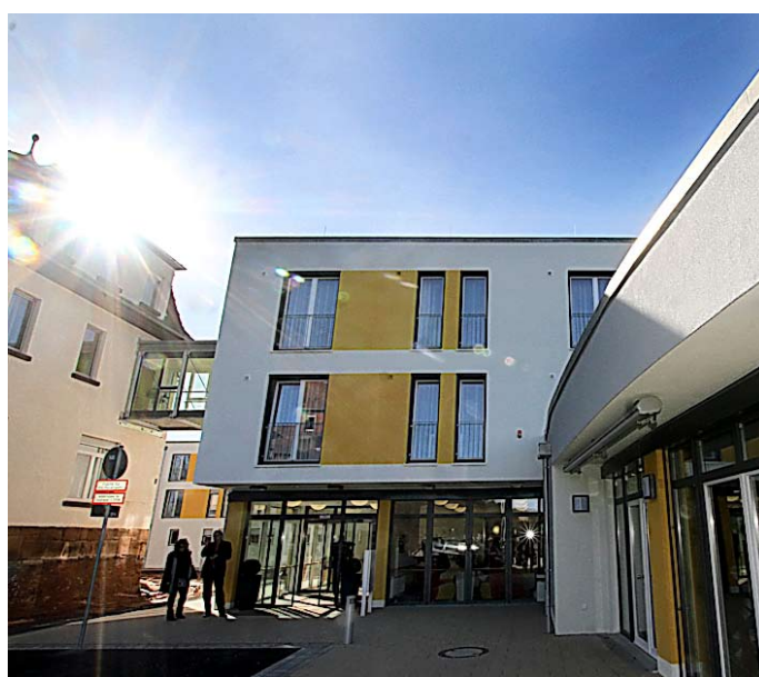
Direkt neben dem alten Elisabethenhof (links) entstand der Neubau. Ein Übergang verbindet die Häuser. Foto: Thorsten Richter
