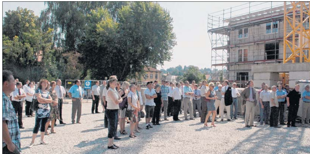
Eine stattliche Zahl geladener und auch Zaungäste hatte sich am Freitagmittag am Rohbau des Seniorenzentrums eingefunden, um der Richtfestzeremonie beizuwohnen.
